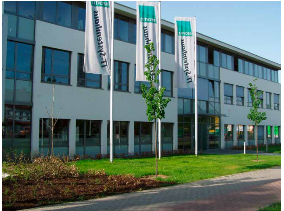
Das Bechtle Systemhaus in Darmstadt ist Teil des dichten Netzwerks der Bechtle Gruppe, zu der mehr als 60 IT-Systemhäuser in Deutschland, Österreich und der Schweiz gehören.
